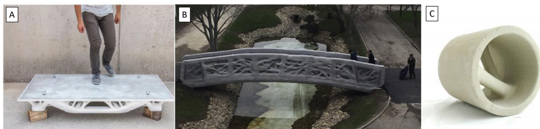
Figure 1-3 : Exemple d'impressions : (A) Dalle par Menges[7], (B) pont par D-Shape à Madrid par Acciona[10] et (C) une conduite par Talke[8]
