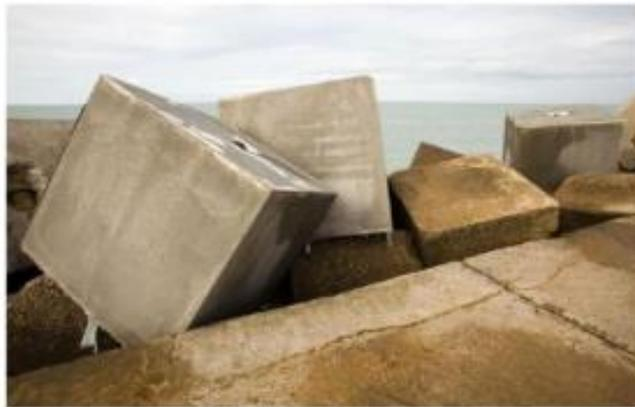
Figure 1. 8. Blocs en béton à base de sédiments [63]
