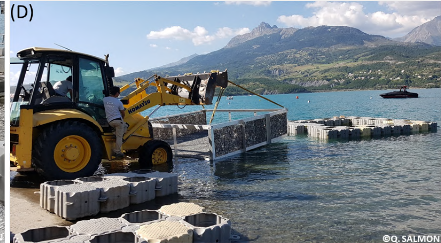
Figure 8 : Photographies des différentes étapes de l'assemblage des FLOLIZs. (A) Assemblage des caissons flottants MarineFloor® (partie émergée); (B) Assemblage des barres en aluminium pour constituer le squelette (partie immergée); (C) Fixage des cages grillagées contenant les substrats minéraux sur le fond et les côtés latéraux du squelette en aluminium; (D) Mise à l'eau des squelettes en aluminium pour assemblage avec la partie flottante. ©Projet UROS
