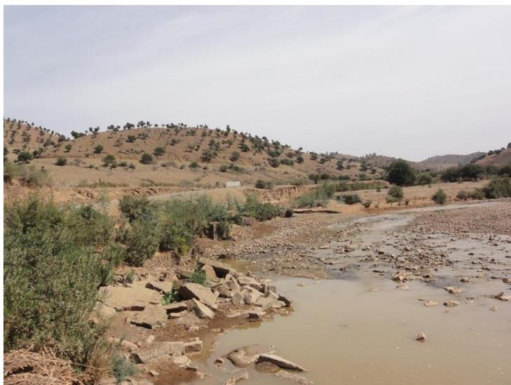
**Fig. 113:** Erosion de berge, en bas à gauche l'effondrement d'une digue de protection
