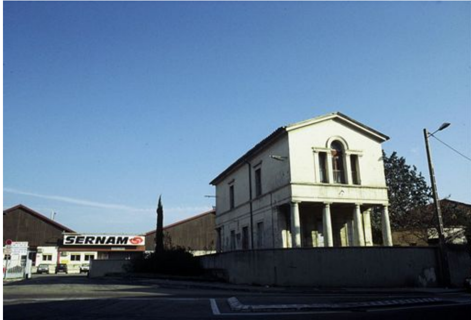
Fig. 89 – Vue de la gare d'Uzès aujourd'hui – (photo de l'auteur)
