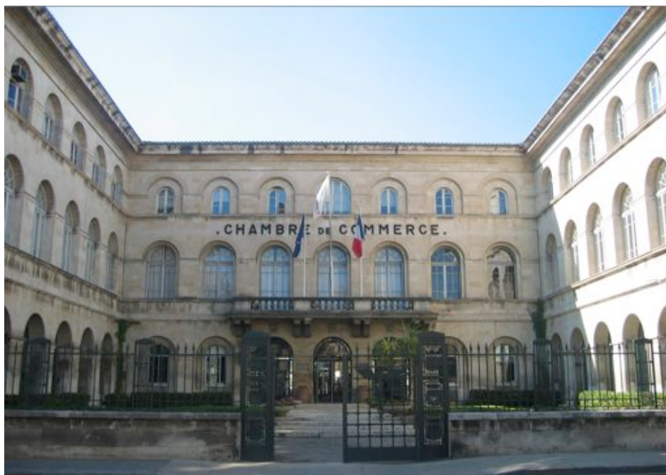
Fig. 69 – Cour intérieure de l’Hôtel-Dieu de C. Durand, aujourd’hui Chambre de Commerce (photo de l’auteur)
