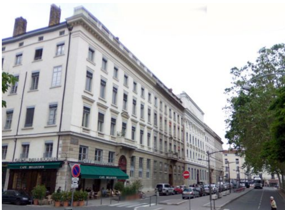
Fig. 54 – Façades place Bellecour à Lyon (Extrait Google Street view)
