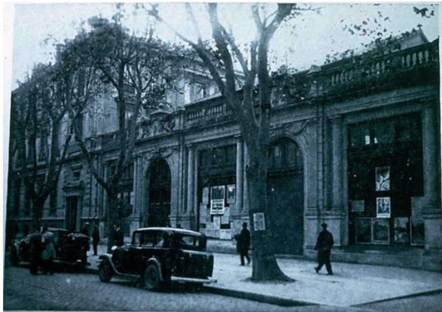
Fig. 252 - Entrée de l'ancien hôtel Olivier, aujourd'hui démolie et remplacée par une construction récente de la Chambre de Commerce – cpa – (AMA)
