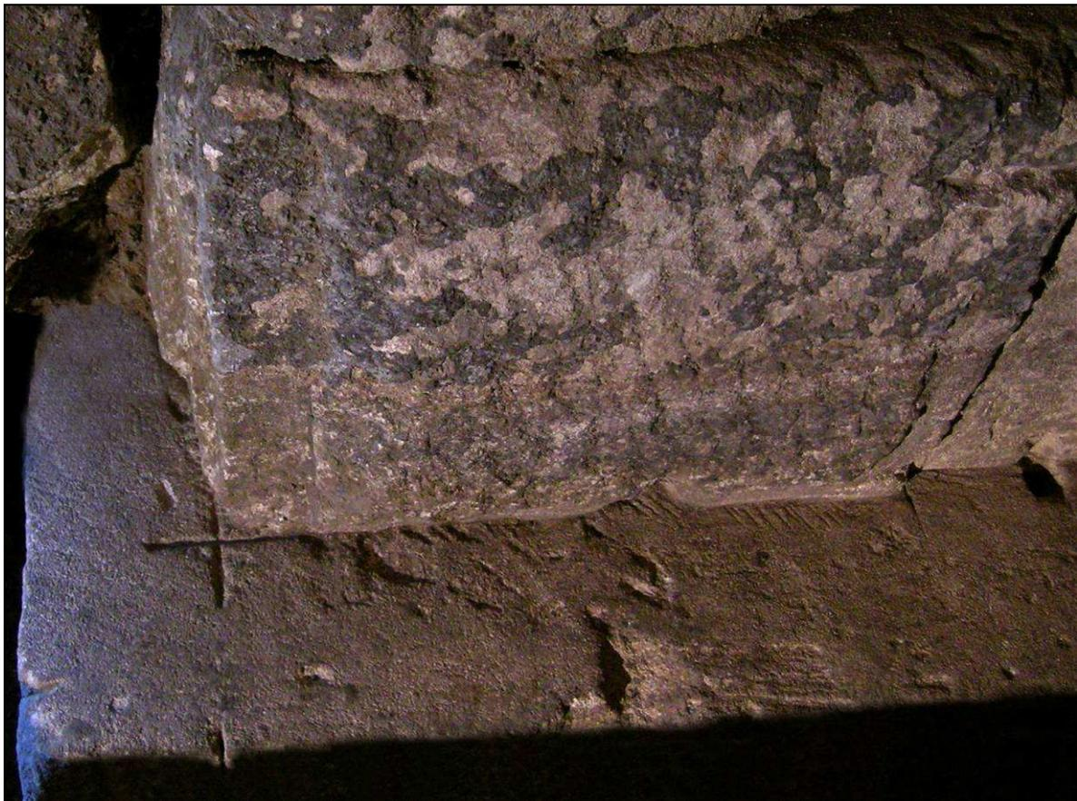
Figure 54 : Apt. AV44. Les marques et coordonnées gravées sur la semelle de fondation du pilier n°3
