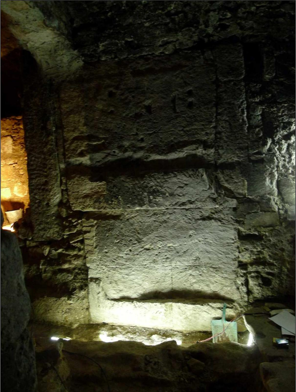
Figure 157b : Apt. AV477. L'agencement des *opus quadratum* dans la construction du pilier (cliché P. De Michèle 2012)
