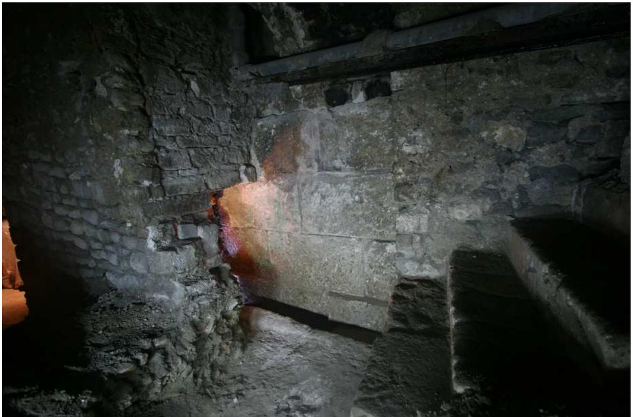
Figure 141 : Apt. AV270a. Le caniveau et les dalles de couverture du collecteur d'eaux usées (cliché P. De Michèle 2012)
