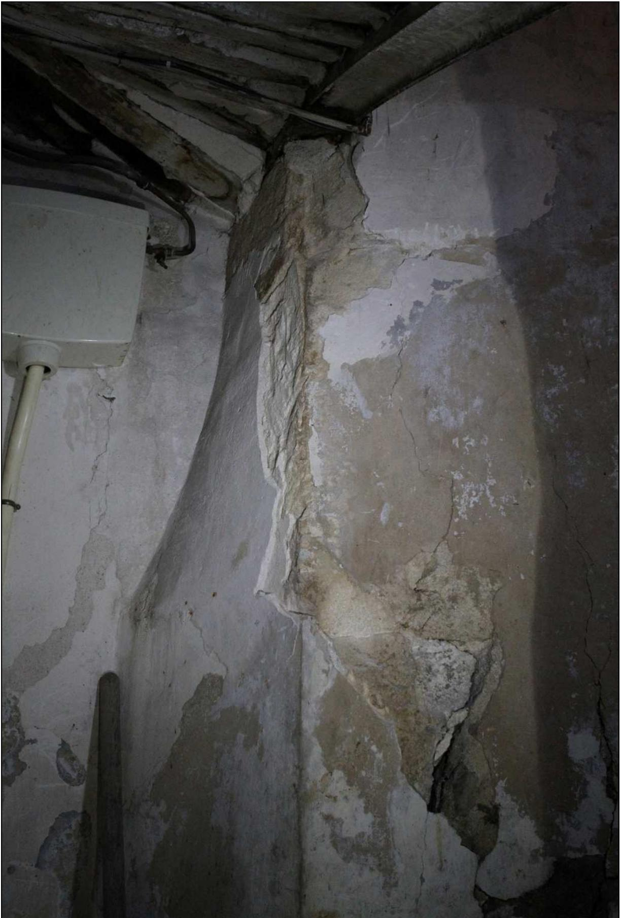
Figure 147 : Apt. AV264. Les assises de l'arc antique au rez de chaussée
