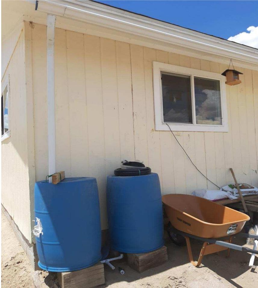
*Figure 35. Photo d'un des chéneaux que nous avons installés, avec les deux citernes et la pose d'un robinet pour diriger son arrivée. Comme de nombreuses maisons de la réserve, celle-ci ne disposait pas de canalisations. Juillet 2020, Shiprock.*
