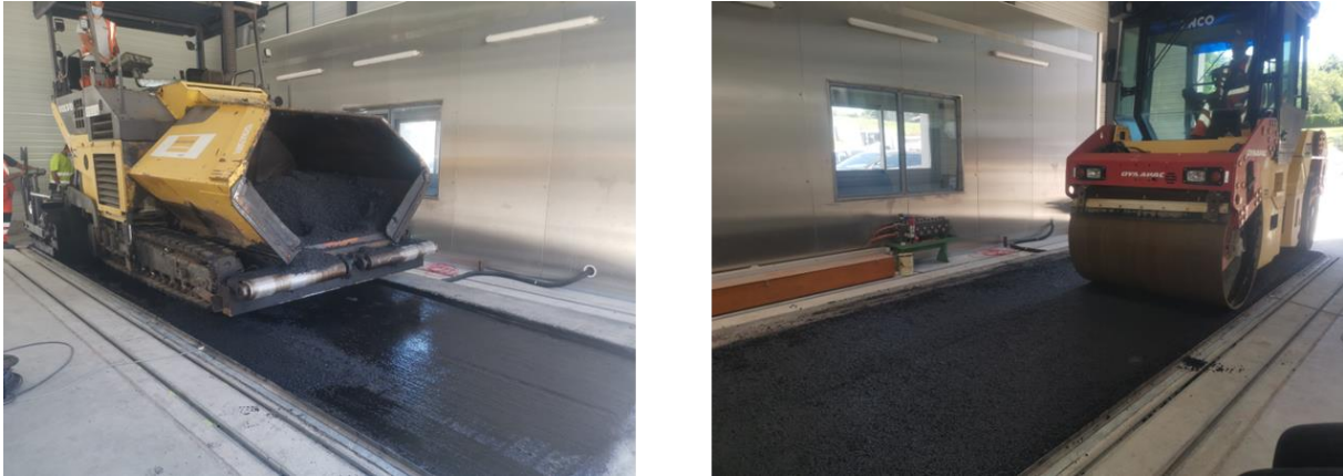
Figure 120 Mise en œuvre du BBAO+
