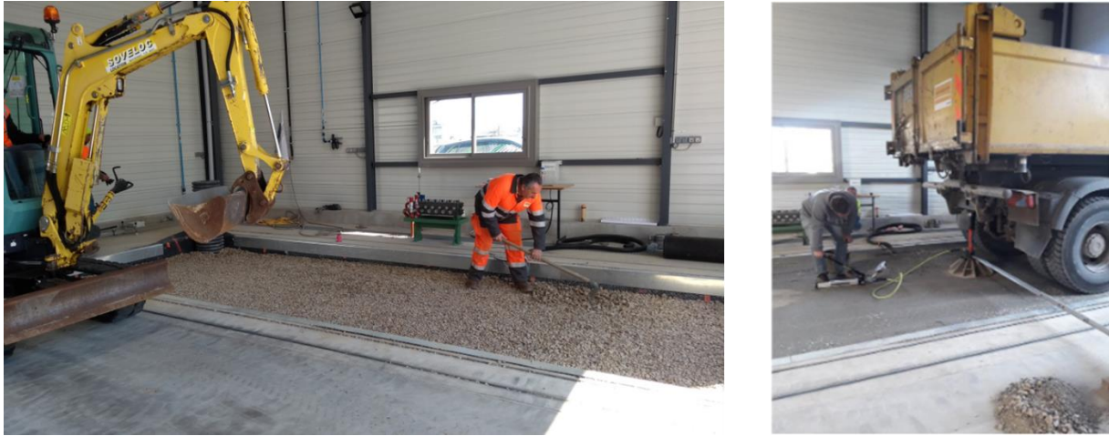
Figure 118 Remplissage de la fosse (gauche) et l'essai de plaque (droite)
