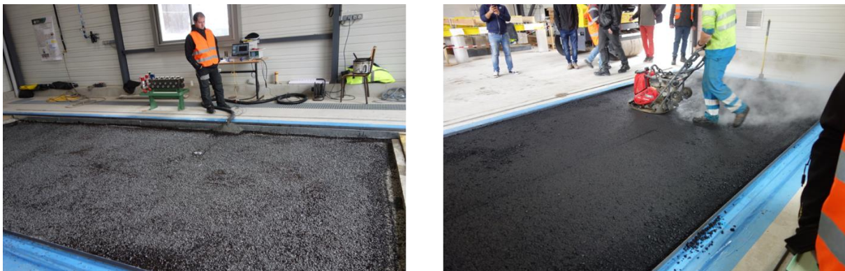
Figure 119 Mise en œuvre de la couche de GB \epsilon + dans la fosse
