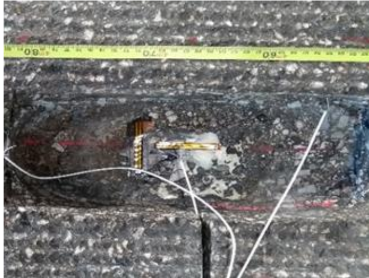
Figure 128 Jauges de déformations collées sur la surface supérieure du GBE+
