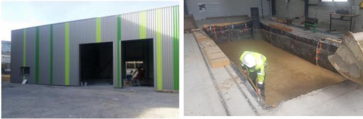
Figure 116 Le hall de recherche (gauche) et une étape de remplissage de la fosse (droite)
