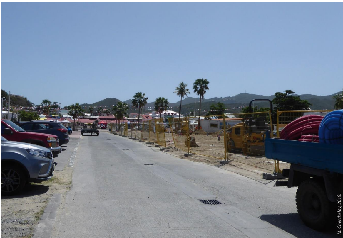
Photographie 36. Début des travaux sur le front de mer à Marigot, 2019.
