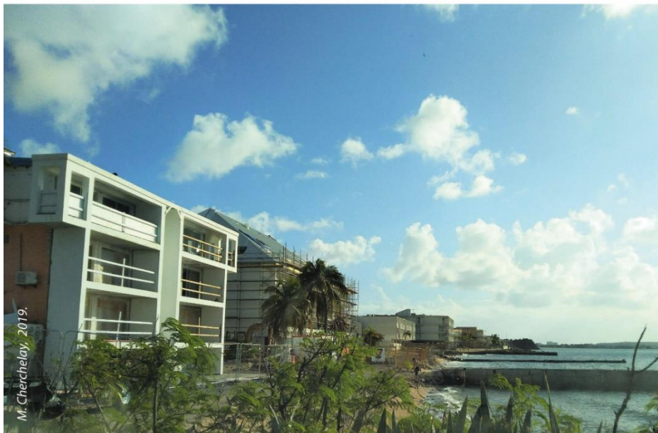
Photographie 25. En haut, résidences et hôtels en travaux dans la Baie de Marigot en avril 2018 ; en bas, les mêmes résidences et hôtels de la Baie de Marigot en août 2019
