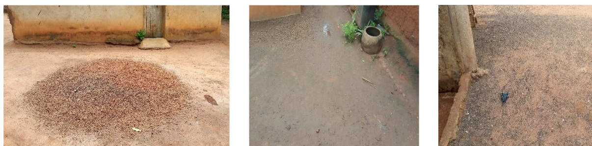
Figure 13 : Technique de stabilisation des sols par les CNP, utilisée par les populations des zones productrices de palmier à huile au Bénin
