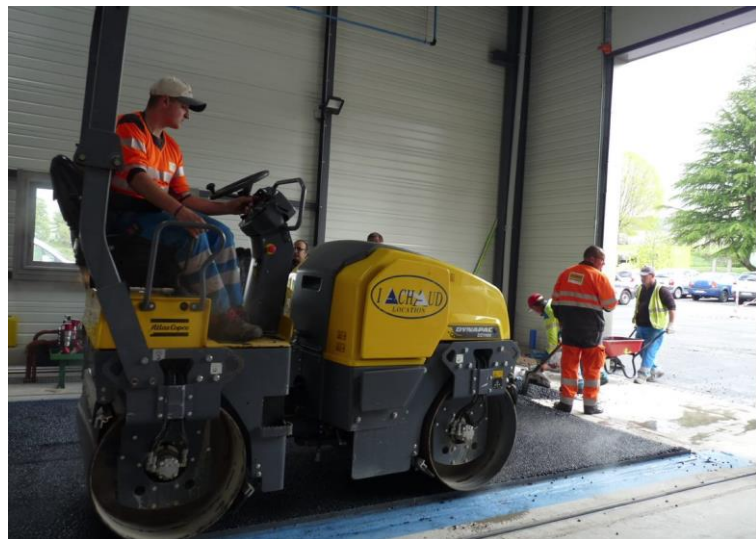
Figure II-11 : Compactage de la couche de roulement
