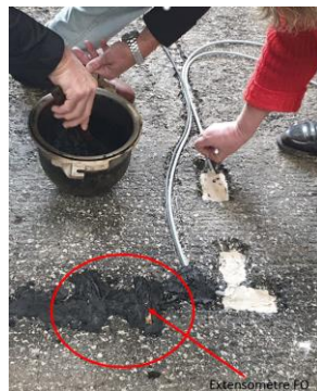
Figure II-23 : Mis en place de l'extensomètre FO
