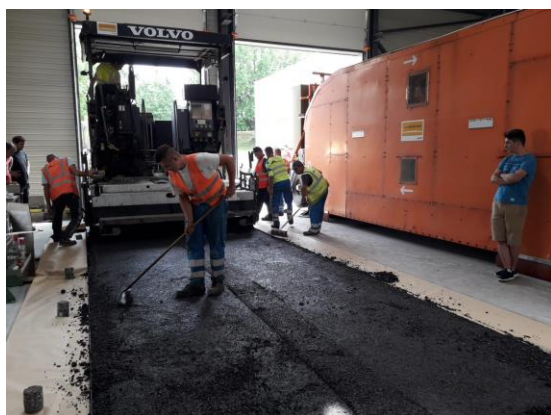
Figure II-14 : Mise en œuvre de l'Agreco sur la fosse
