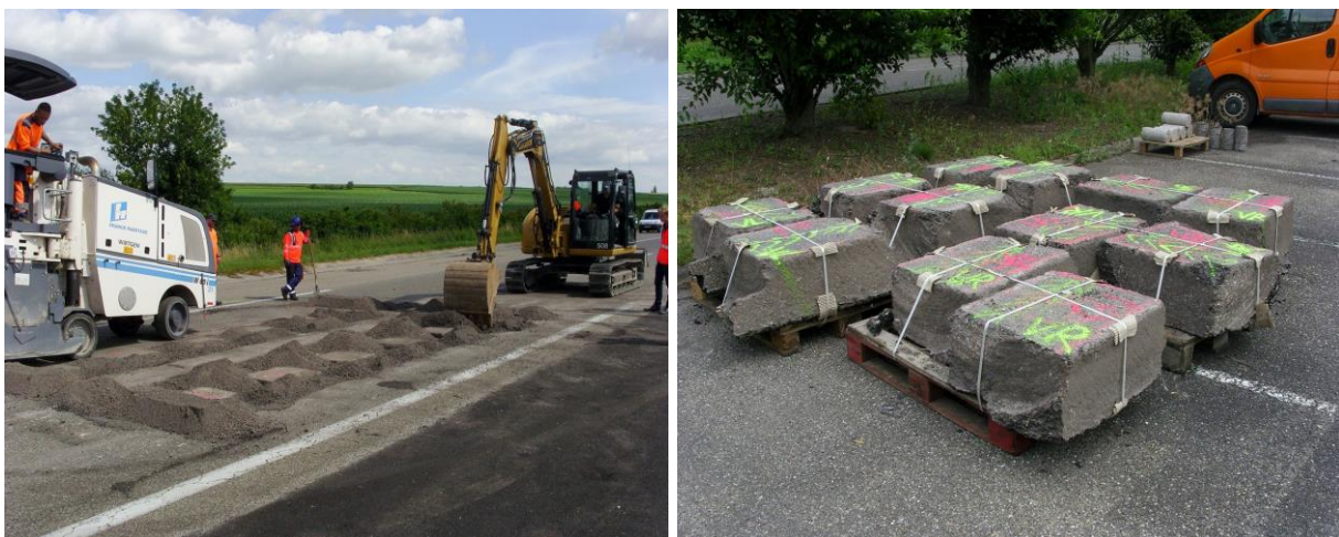
Figure II-3 : Découpe et prélèvement des blocs de la A35
