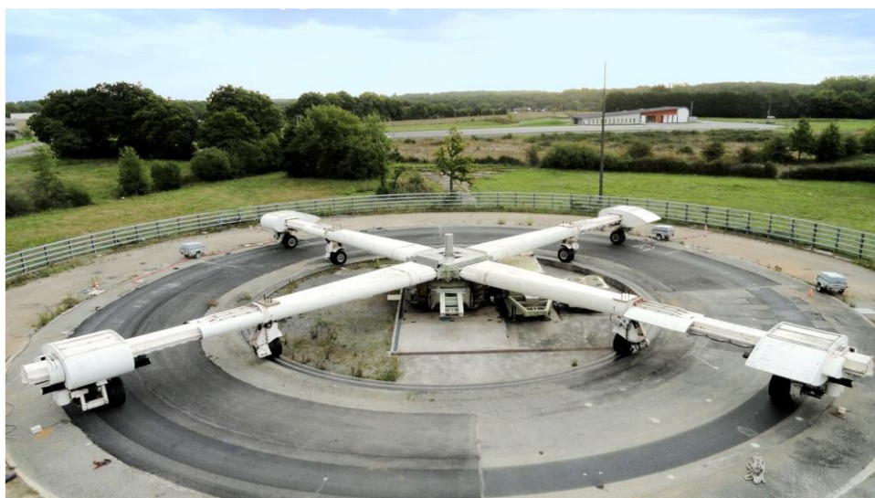
Figure II-14 : Manège de fatigue de l'UGE à Nantes
