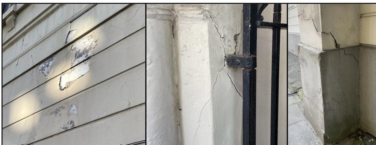
FIGURE 3.4 – Photographies d’effets de fractures et de peeling. De gauche à droite : peeling de la peinture d’un mur, apparition de craquelures autour de la fixation d’un portail, fissures d’un mur conséquence de la déformation du sol.
