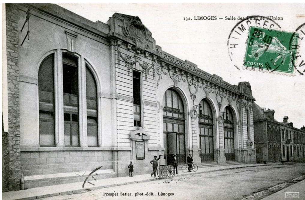
Figure 14. Façade principale de la salle de l'Union, rue de la Fonderie (actuellement rue des Coopérateurs), s.d. 180
