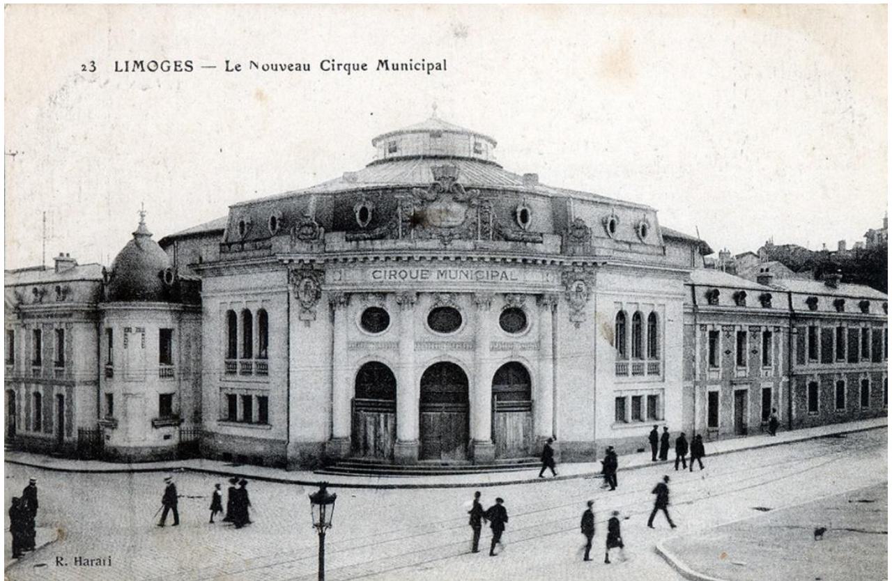
Figure 12. Le nouveau Cirque municipal de Limoges, construit en dur peu après la Grande Guerre, place de la République, s.d. 162
