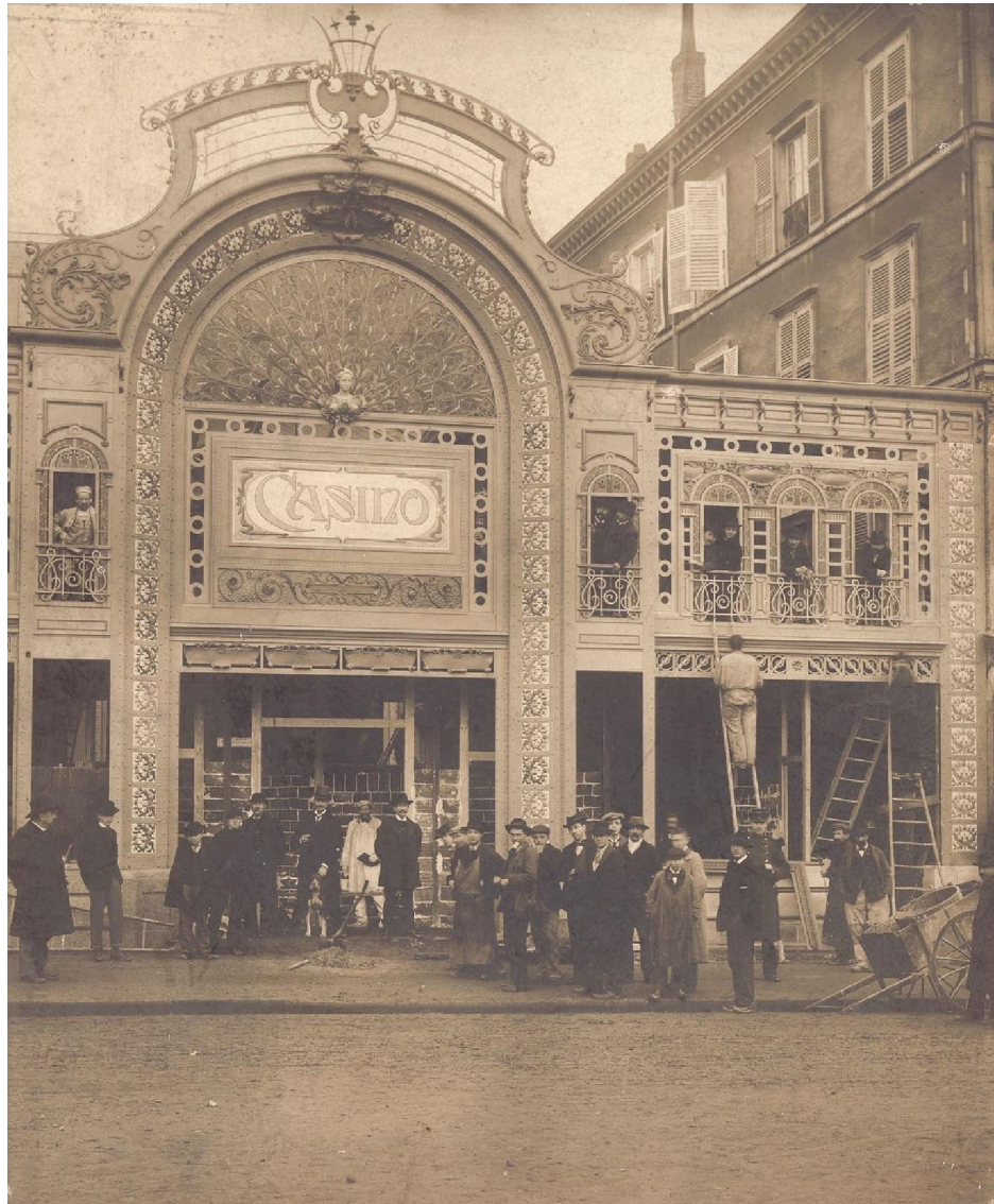
Figure 7. Façade du Casino de Limoges, vers 1901. 142
