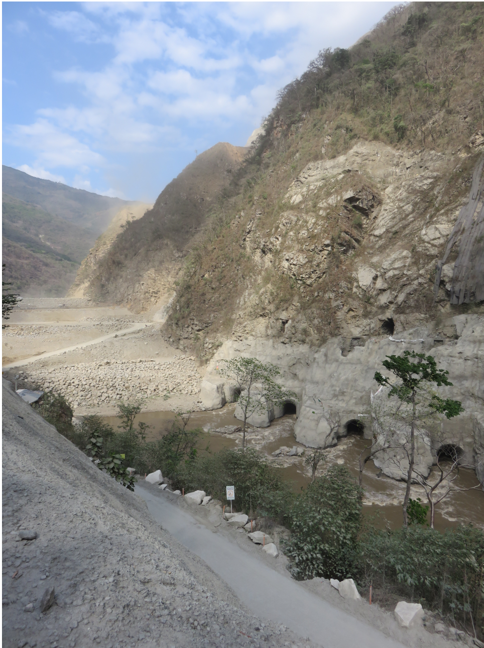
Photo 2: Tunnels de déviation en aval de la digue en construction, municipe d'Ituango (auteur Benassaya, 2016)
