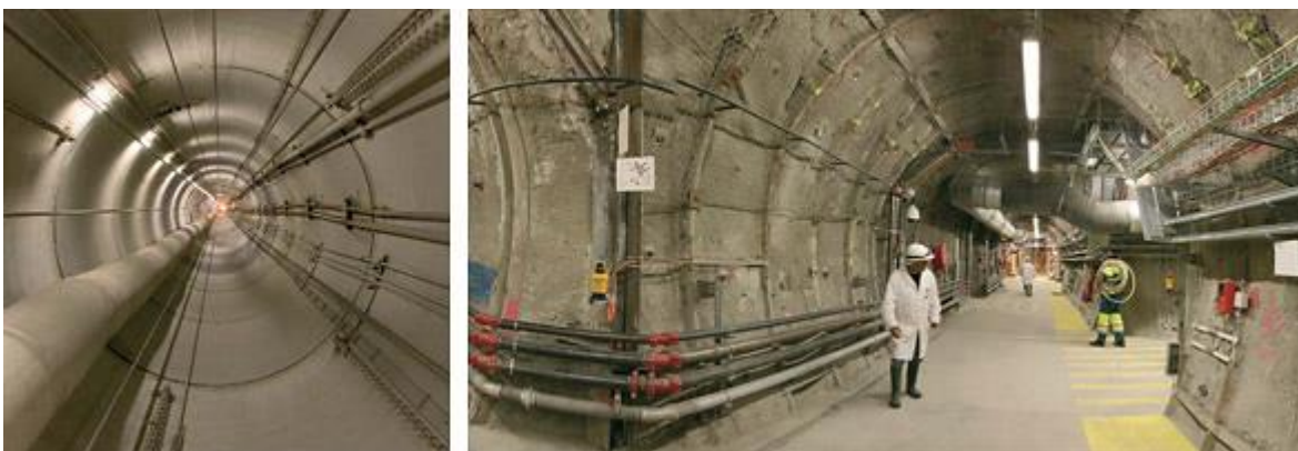
Figure 10. Puits d'accès au laboratoire souterrain (à gauche) et galeries (à droite).
