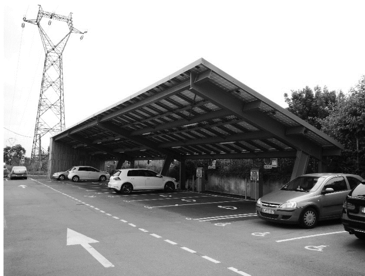
Figure 62 : Ombrière photovoltaïque à Lomme.
