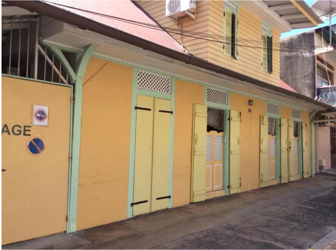
Figure 14 : Maison créole réhabilitée en rez-de-chaussée
