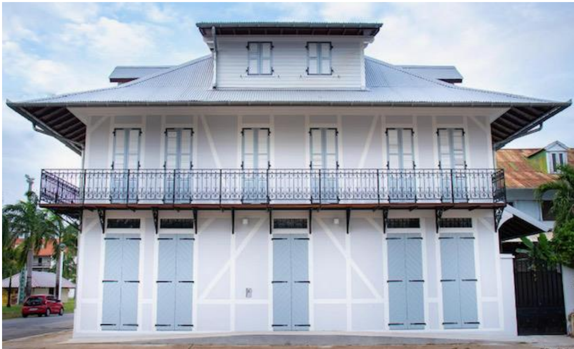
Figure 15 : Maison créole réhabilitée à un étage
