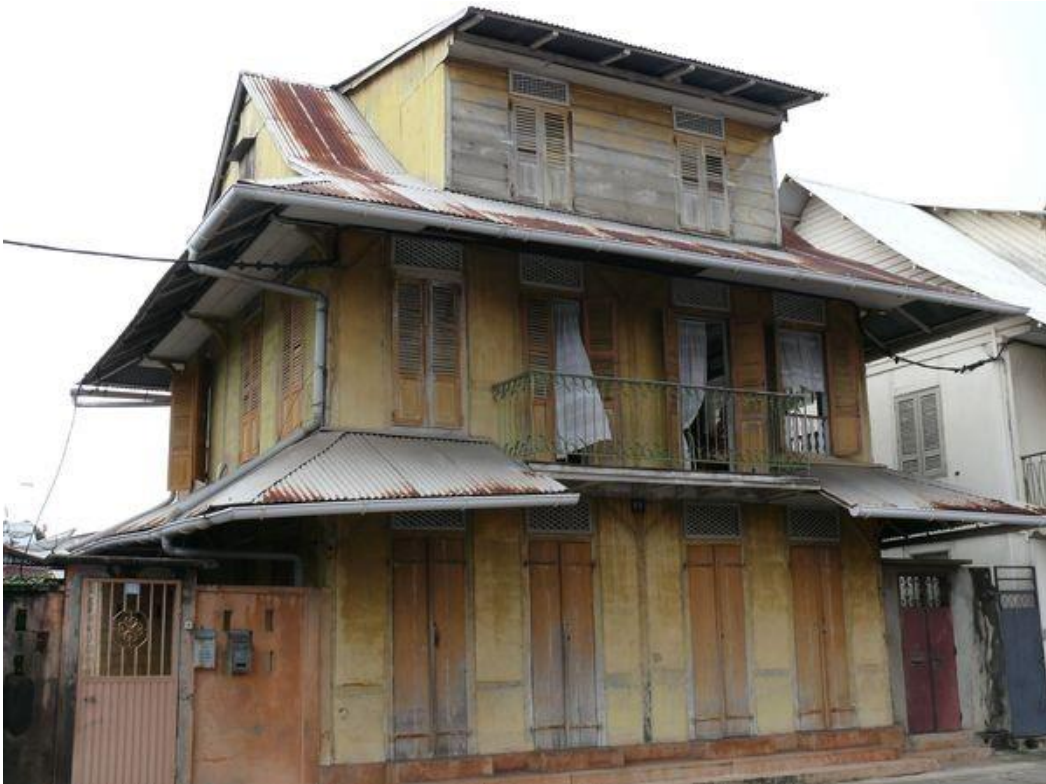
Figure 17 : Maison traditionnelle créole non réhabilitée
