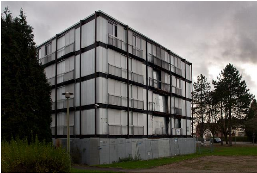
Photo 7 : Un immeuble d'habitation de la cité de la Grand Mare à Rouen, construit en 1968 et 1970, dessiné par Lods. On retrouve la structure porteuse métallique extérieure, ici simplement peinte. Photo Guillaume Painchault, 2011
