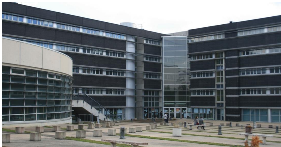
Photo 10 : Pôle santé, le bâtiment principal et la bibliothèque universitaire à gauche, en 2012. Photo Pierre Etienne
