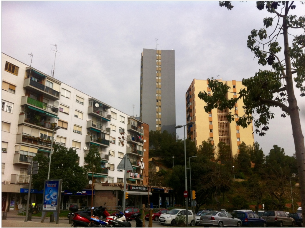
Photographie 2 : Immeubles bordant la place centrale du quartier (Plaza Roja) (2016)
