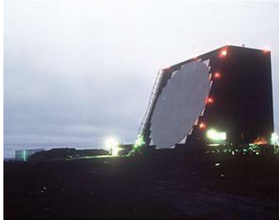
Figure I-25 : Système de surveillance "Cobra Dane" basé sur l'utilisation d'un réseau phasé, établi par les Américains en 1976 dans le cadre de la Guerre froide [16]
