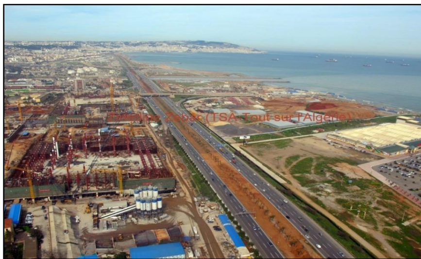
Le projet en cours de construction, Source : Zinedine Zebar (TSA Tout sur l'Algérie) Déc 2015.
