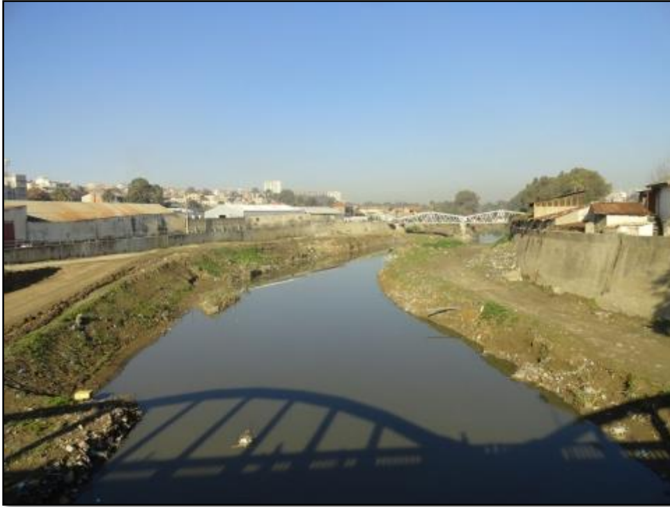
Figure 114: Oued El Harrach, avant les travaux
