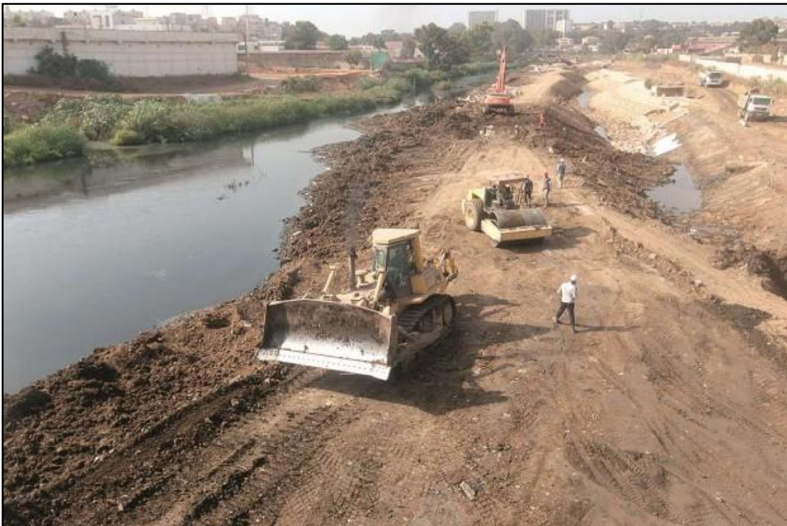
Figure 115: Oued El Harrach, pendant les travaux
