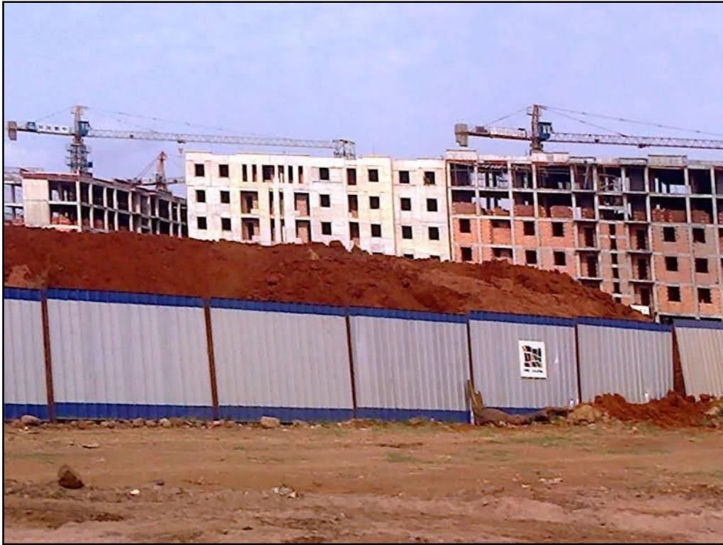
La ville nouvelle en cours de construction, source : ANSA
