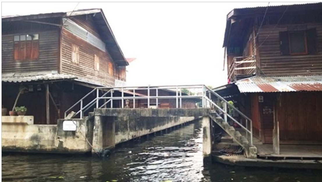
Photographie 3.15 : Village de la zone Sud (C5) : croisement des axes d'évacuation de l'eau avec un mur anti-inondation construit d'un seul côté du canal
