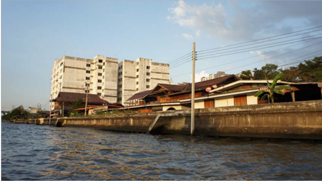
Photographie 3.9 : Mur anti-inondation le long du khlong Bangkok Noi (zone Nord du terrain d'étude)
