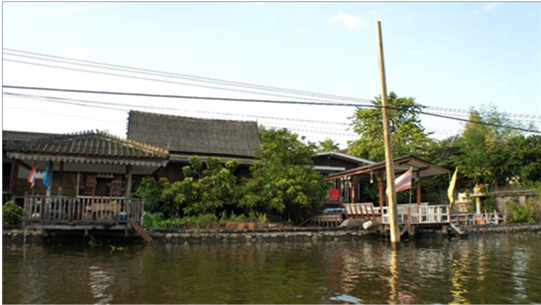
Photographie 3.13 : Maisons au bord du khlong Chakphra équipées de digues au niveau du sol pour la protection contre l'érosion provoquée par les bateaux à moteur
