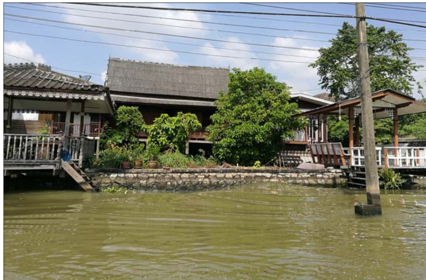
Photographie 2.26 : Enrochement des berges au long du khlong Chakphra fait par les propriétaires
