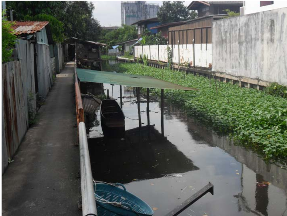
Photographie 2.27 : La construction de la berge (rue piétonne a été construite au dessus) en béton a fermé l'accès au garage à bateau de chaque parcelle
