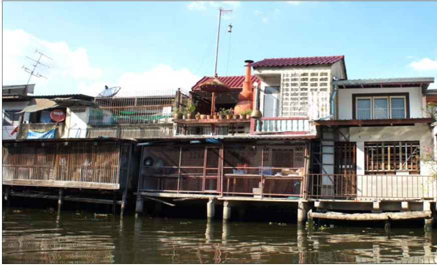
Photographie 2.15 : Transformation de l'espace au bord de l'eau, de l'entrée principale à la partie arrière de maison.
