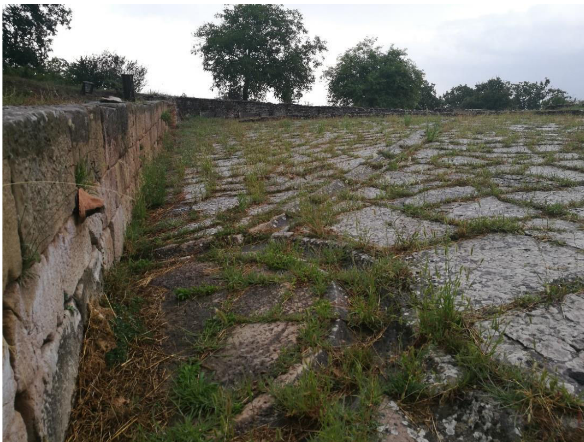
Figure 64 : Sanctuaire de Rossano, caniveau
