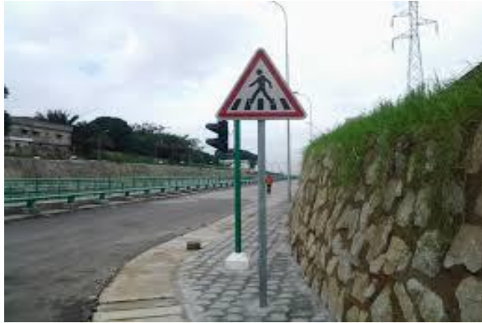
Figure V-13 panneau attention passage piéton à la Riviera 2
