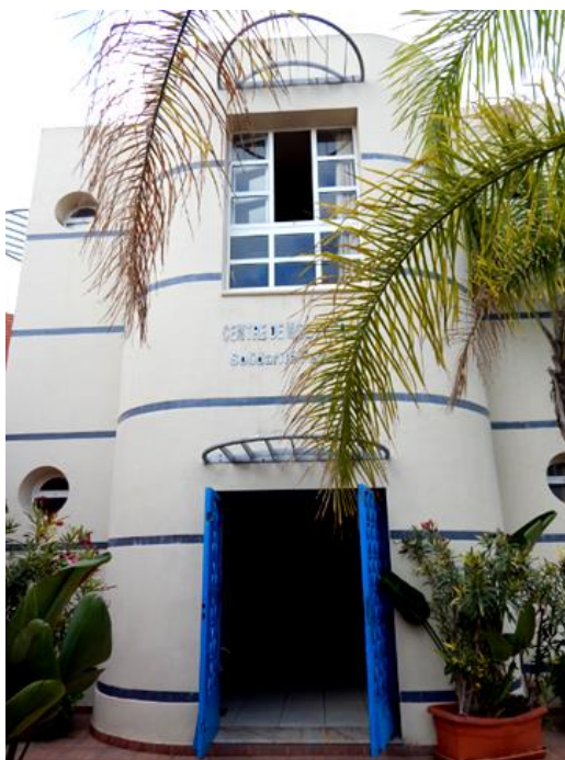
Figure 13. Façade du centre d'accueil et de formation pour mères célibataires de l'ASF
