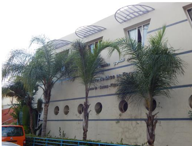
Figure 22. Installations et siège d'ASF au Maârif, Casablanca
