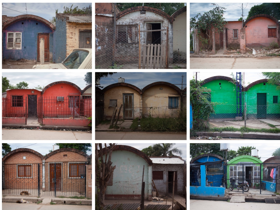
Imagen 37. Fotografías de los frentes de las casas construidas entre 1970 y1974 (crédito: Carolina Soler).
