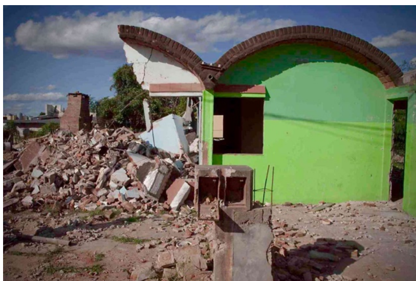
Imagen 38. Fotografía del barrio durante el proceso de demolición (crédito: Carolina Soler).
