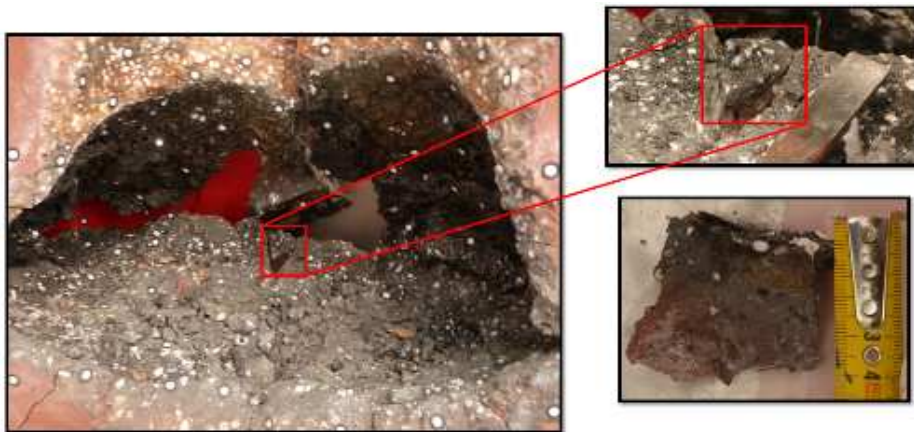
Figure 3-30: Echantillon de béton siliceux prélevé du fond de la surface horizontale de la section d'essai
