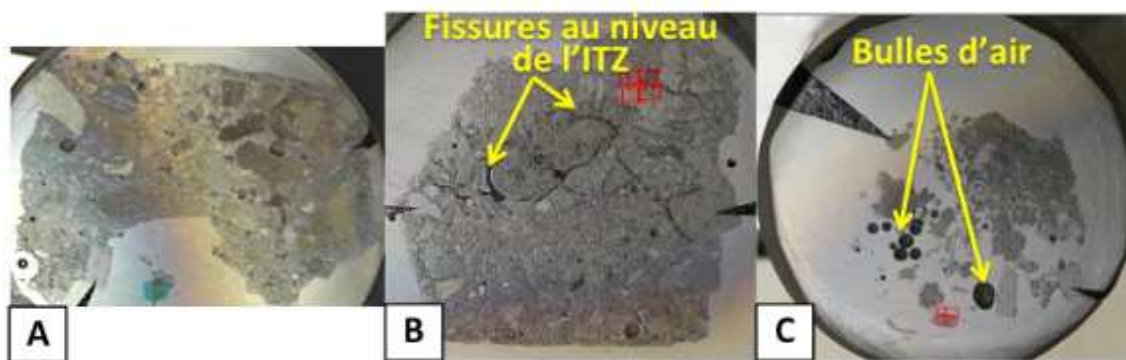
Figure 6-19: Photographie des échantillons de béton S_1 (A), S_2 (B) et S_3 (C) analysés au MEB. Les flèches dans B indiquent la fracturation au niveau de l'ITZ. Celles dans C indiquent des bulles d'air
