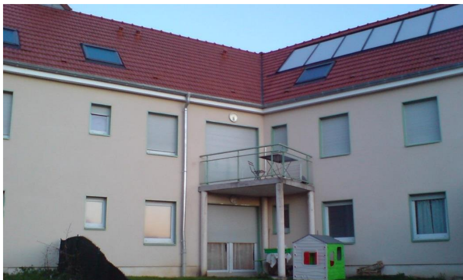
Figure IV. 2 : Vue des façades Est du bâtiment
