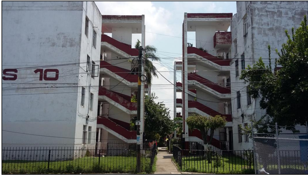
Photographie n°7 : Édification de logement INFONAVIT Estadio. Source : César Barrios, prise le 29/07/2016.
