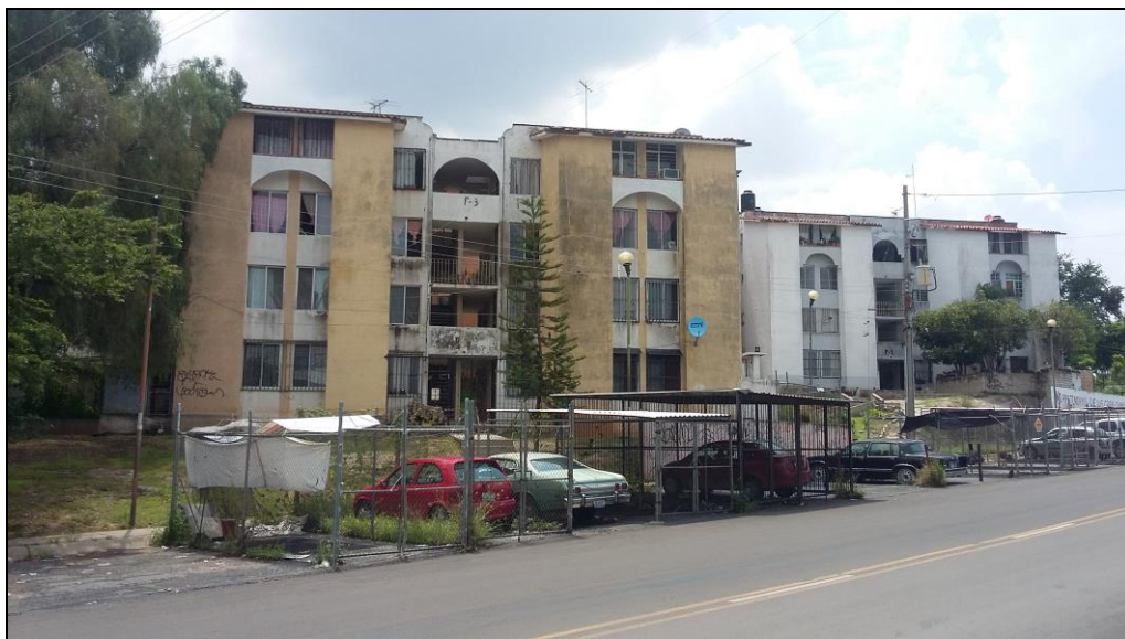
Photographie n°4 : Édification de logement FOVISSSTE Estadio.
