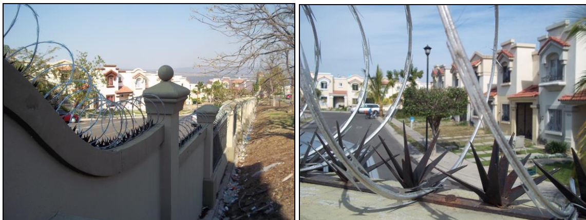
Photographie n°16 (gauche) : Mur protégé à Urbi Matatlán, Tonalá. Source : César Barrios, prise le 20/02/2015.
