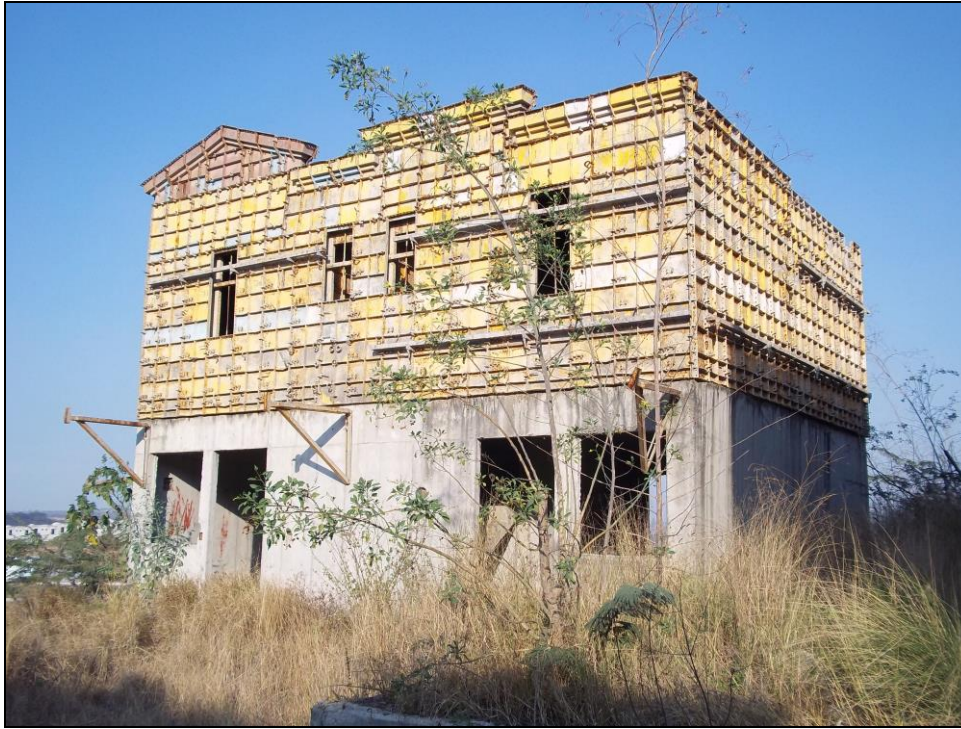
Photographie n°18 : Modèle de construction de coulage, à Urbi Matatlán, Tonalá. Source : César Barrios, prise le 20/02/2015.
