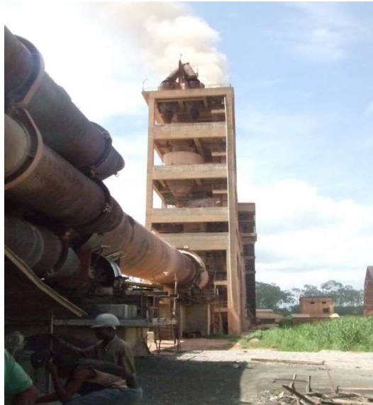
Figure 3 – Emissions dans la cimenterie.
