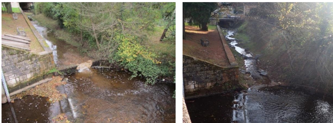
Photos n°12 et 13 : Avant après des travaux sur le seuil ruisseau de Chantres (source : LIFE Haute Dronne)
