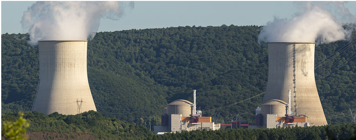
FIGURE 1.5 – Centrale nucléaire de Chooz (Ardennes). Les deux réacteurs sont logés dans les deux bâtiments cylindriques au premier plan. Les cheminées, plus à l'arrière, sont destinées au refroidissement des réacteurs (certaines centrales, refroidies grâce à l'eau d'une mer ou d'un cours d'eau, ne sont pas équipées de telles cheminées) 36
