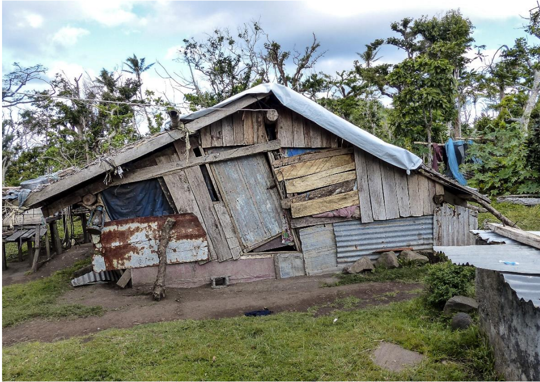
Photographie 31 : La cuisine cabossée et à demi écroulée d'Elda Roy (dite sili sa ). Elle a été conservée en souvenir de l'événement, tel un monument commémoratif de la force de Pam, et réparée tant bien que mal avec les bâches distribuées par l'aide internationale et les morceaux de bois trouvés après le cyclone. Depuis, la famille y loge en attendant de pouvoir construire une nouvelle maison. 10/08/2015, Kurumampe.
