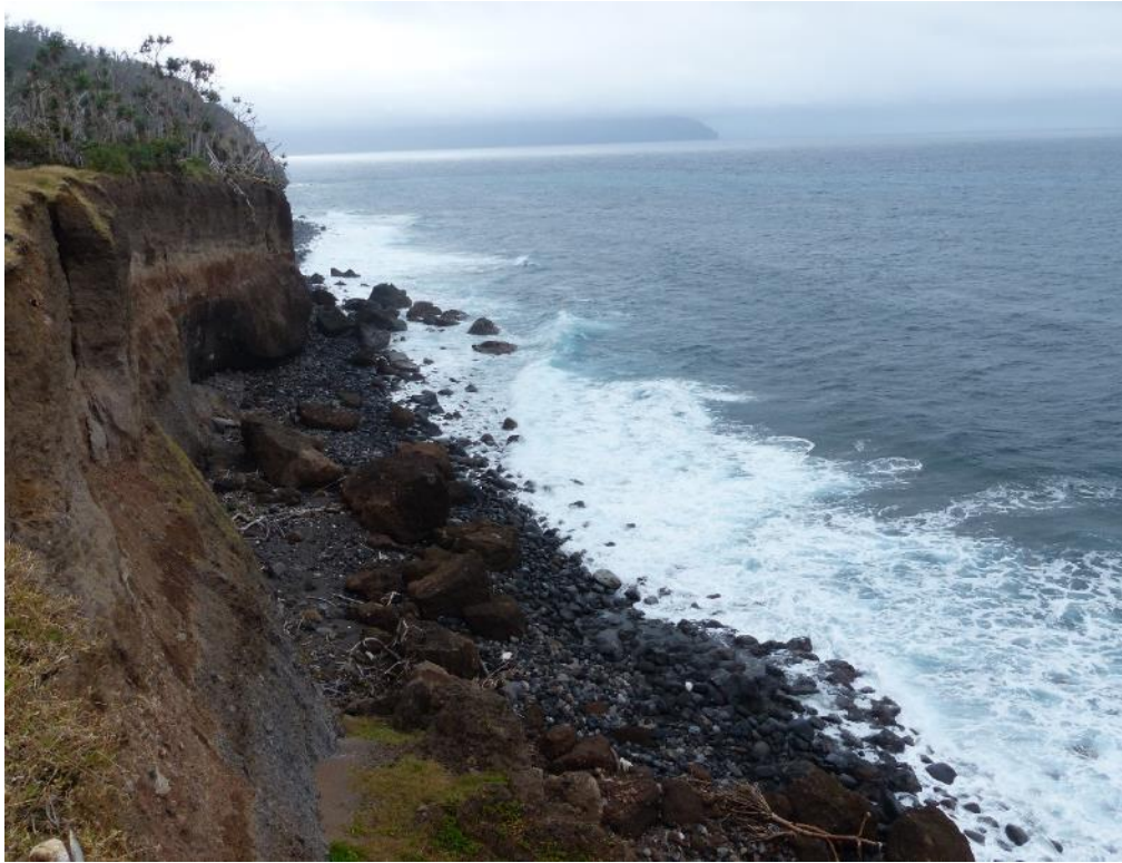
Photographie 18 : Baie dans laquelle se trouve la mer appelée natoro toro , la portion de mer la plus facilement accessible depuis le village, mais aussi l'une des plus exposées aux glissements de terrain. Au loin, on aperçoit l'île d'Emae. Cette photo a été prise après le cyclone Pam. 17/08/2015, Kurumampe.
