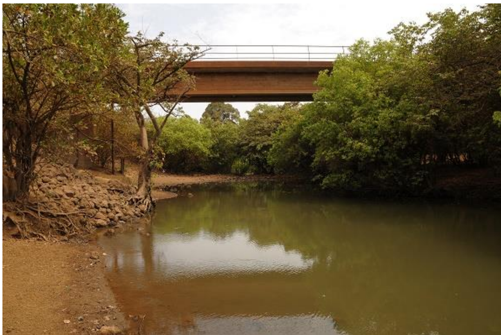
Figure 13 : Photo de la rivière au pont du Badénou entre Odoro et Tiébila, sur l'axe Korhogo – M'Bengué (février 2014)
