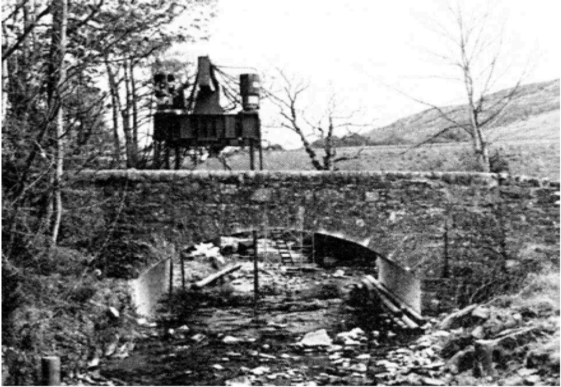
Figure 76 : Le Shinafoot Bridge avant l'essai.
