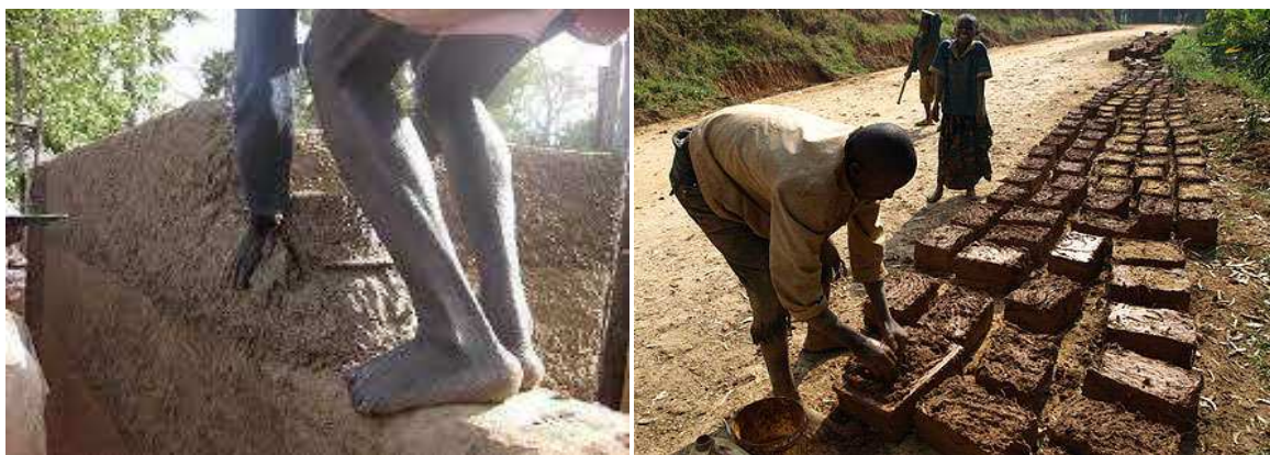
Figure II.3 : Construction de l'habitat social en terre crue.
