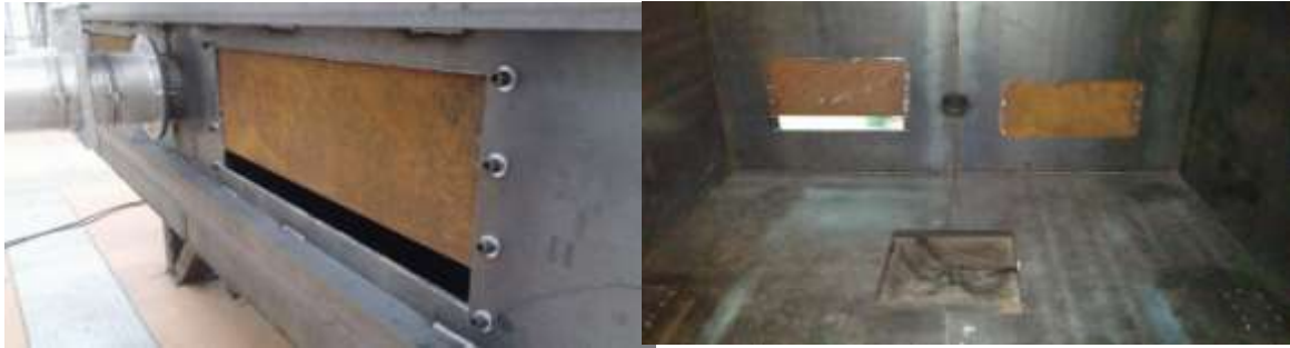
Figure 15 :Ouvertures de ventilation naturelle.
