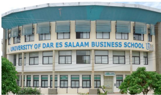
Bâtiment principal de l'UDBS 28/04/2013, Dar es Salaam © Olivier Provini
