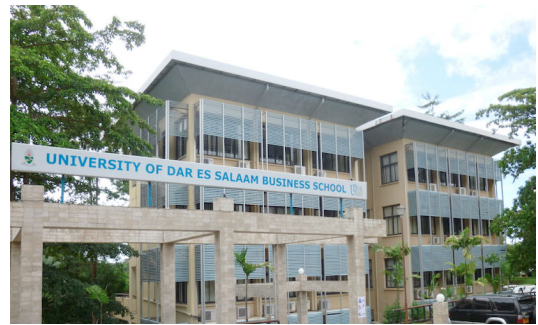
Bâtiments de l'UDBS 28/04/2013, Dar es Salaam © Olivier Provini
