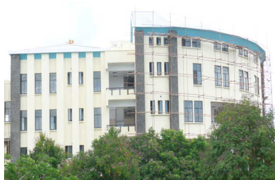
Bâtiments en construction de l'UDBS 28/04/2013, Dar es Salaam © Olivier Provini
