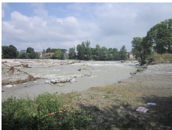
Photographie 31 : la passe à poisson de Mazères-Lezons détruite suite à la crue de 2013 (Leichnig, juillet 2013)
