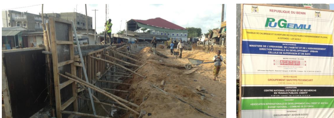
Planche 14 : Travaux de calibrage et d'assainissement (à gauche) et panneau de chantier (à droite) du PUGEMU : Bassin AA à Fidjrossè
