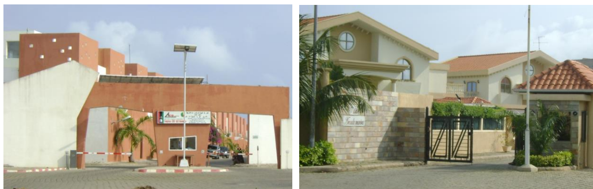
Planche 7 : Villas SEN-SAD : Pavillon de la Libye et Pavillon situé à l'Ouest du Palais des Congrès
