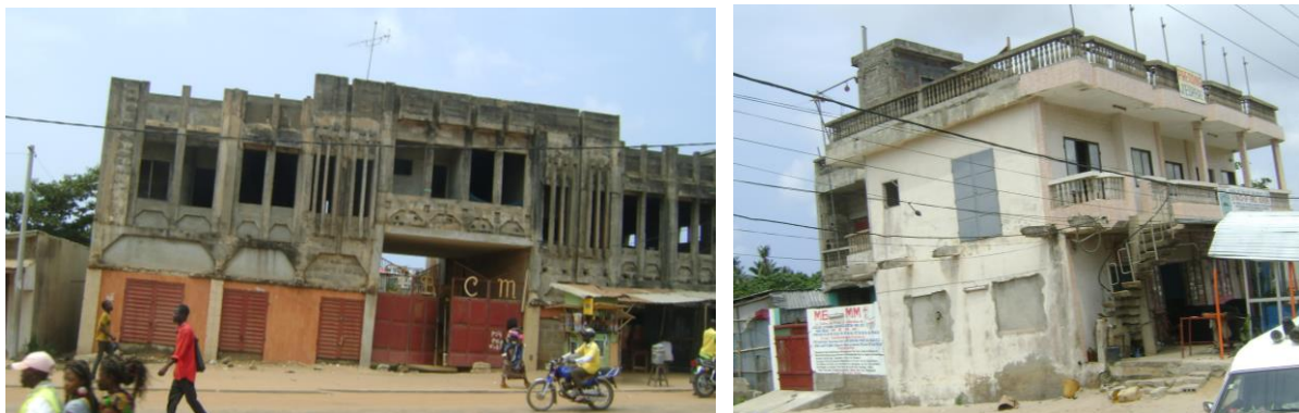
Planche 6 : Immeubles inclinés construits sans autorisation administrative le long de route nationale inyer-état n°1 à Kondonou non loin de l'échangeur de Godomey (à gauche) Menontin (à droite)
