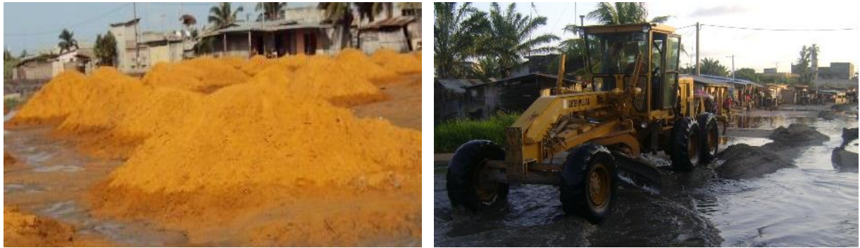
Planche 13 : Remblayage avec du sable latéritique (à gauche) et évacuation des eaux par engin mécanisé (à droite)
