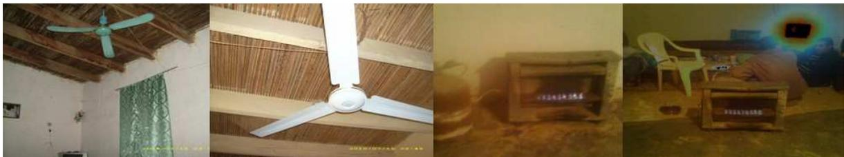
Figure II-14 : Moyens de régulation thermique utilisés « maison en terre et paille »
