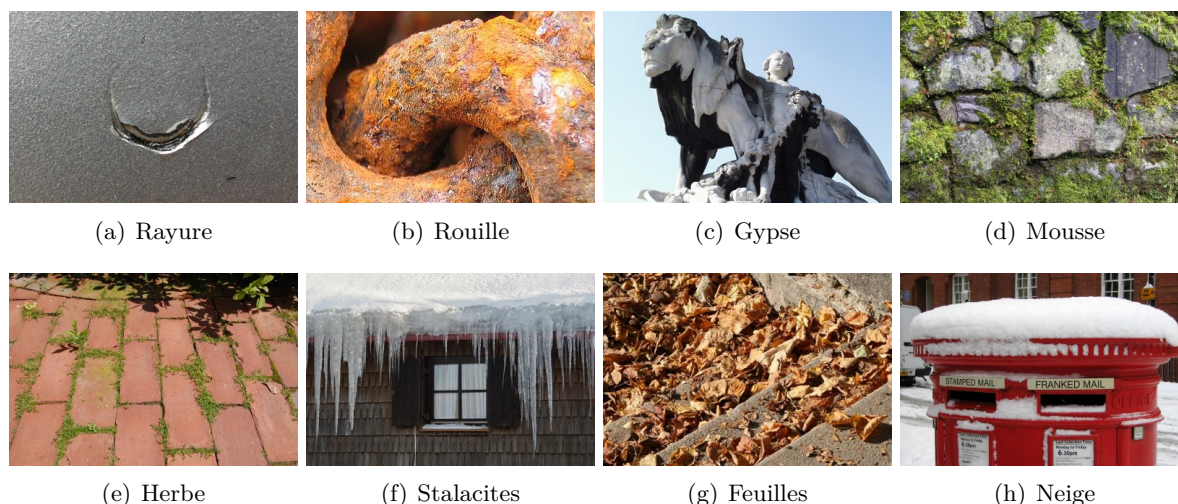
FIGURE 1.3 – Exemples réels de variations d'apparences. De gauche à droite : rayures causées par un choc mécanique, formation de rouille due à la corrosion du métal, formation de gypse causée par la pollution, croissance de mousse sur un mur, croissance d'herbe entre des pavés, formation de stalactites au bord d'un toit, dépôt de feuilles mortes, couche de neige.
