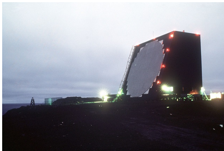
FIGURE 1.11 – Système de surveillance "Cobra Dane" basé sur l'utilisation d'un réseau phasé, établi par les Américains en 1976 dans le cadre de la Guerre froide. [14]
