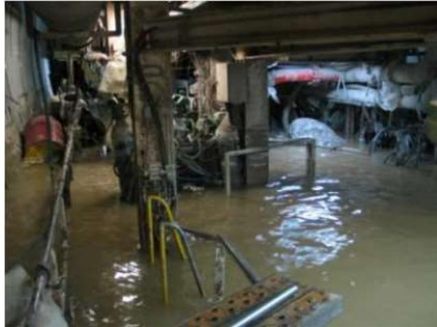
Figure 5 : Exemple d'un tunnel noyé (source NFM technologie 2011).
