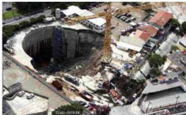
Figure 6 : Exemple de l'effondrement d'un tunnel en cours de construction, Station de métro à Sao Paulo en 2007.
