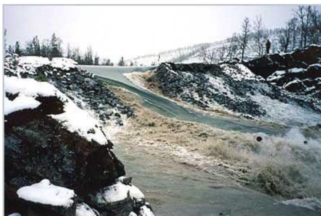
Figure 30 – Phase d'élargissement d'une digue en moraine et enrochements (projet IMPACT).
