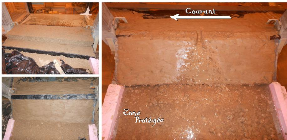
**Figure 50** – Etapes de la construction de la digue et situation initiale ; l'écoulement côté rivière va de la droite vers la gauche (il en sera ainsi sur toutes les photos de ce chapitre sauf mention contraire).
