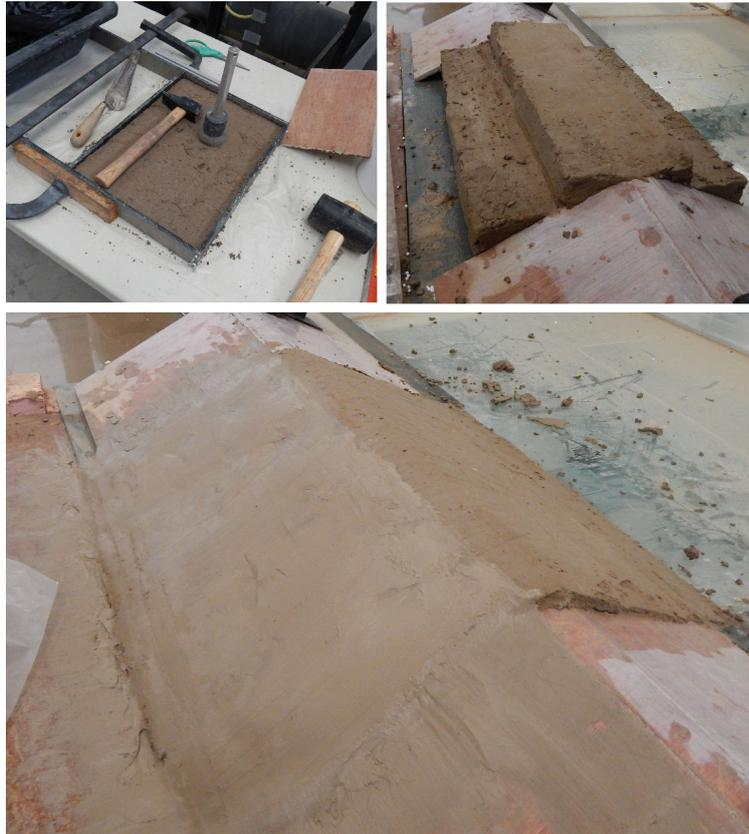
**Figure 120** – Phases de construction d'une digue. Préparation des éléments compactés, construction par étages puis réalisation de la pente du parement (sur la photo, le parement côté rivière n'a pas encore reçu sa couche d'argile pure).
