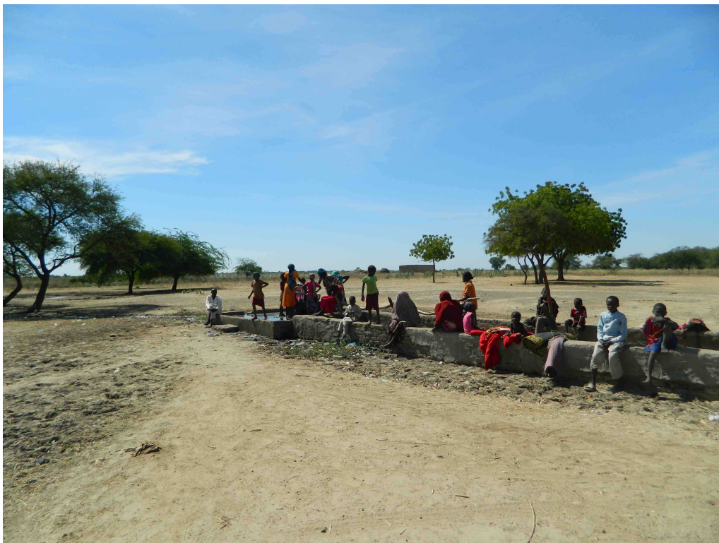
Forage artésien de Amboung.
