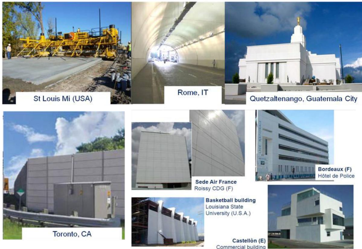
**Figure 14 : Exemples de constructions en ciment photocatalytique réalisées par le groupe industriel Italcementi Group, à des fins de dépollution de l'air (revêtement de route à St Louis, MI, USA, revêtement de tunnel à Rome, IT ou mur anti-bruit à Toronto, CA) ou pour obtenir des propriétés autonettoyantes (à Guatemala City, Roissy CDG, Bordeaux, Louisiana State ou à Castellon).<sup>87</sup>, soit tu donnes des noms de ville et de pays ou que de villes ou que de pays ...**
