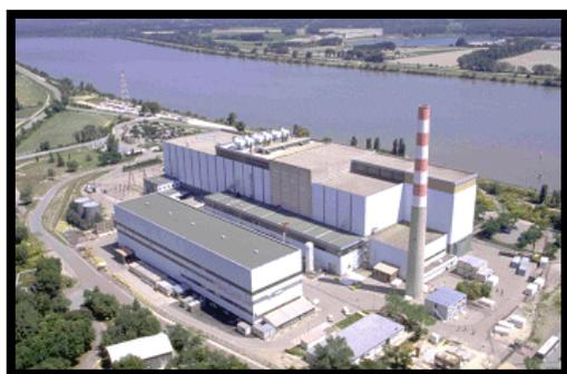
PHÉNIX a été le démonstrateur français nucléaire de la filière nucléaire à neutrons rapides et à caloporteur sodium, conçu pour générer une puissance électrique de 250 MWe et situé sur le site nucléaire de Marcoule. Phénix a été construit en 1968 et a divergé le 31 août 1973.
