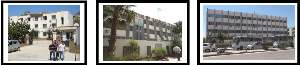
Fig. 49: Siège de la mairie (à gauche) et de la wilaya (au milieu), ainsi que le bloc administratif au niveau de la rue de la Liberté, dont la forme et la position ne permettent pas une participation dans la structuration et le fonctionnement de l'espace public. Celui-ci ne s'identifie pas au pouvoir administratif comme c'est le cas de l'hôtel de ville.
